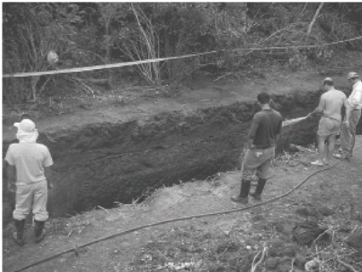
Figura 33. Lavado a chorro de las paredes de la trinchera y demarcación con cinta de seguridad.
