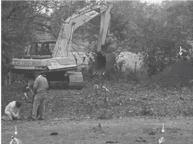
Figura 30. Inicio de la excavación de la trinchera de exploración paleosismológica Los Gomos. Las líneas de estacas delimitan, al este y al oeste, la zona que va excavarse.
