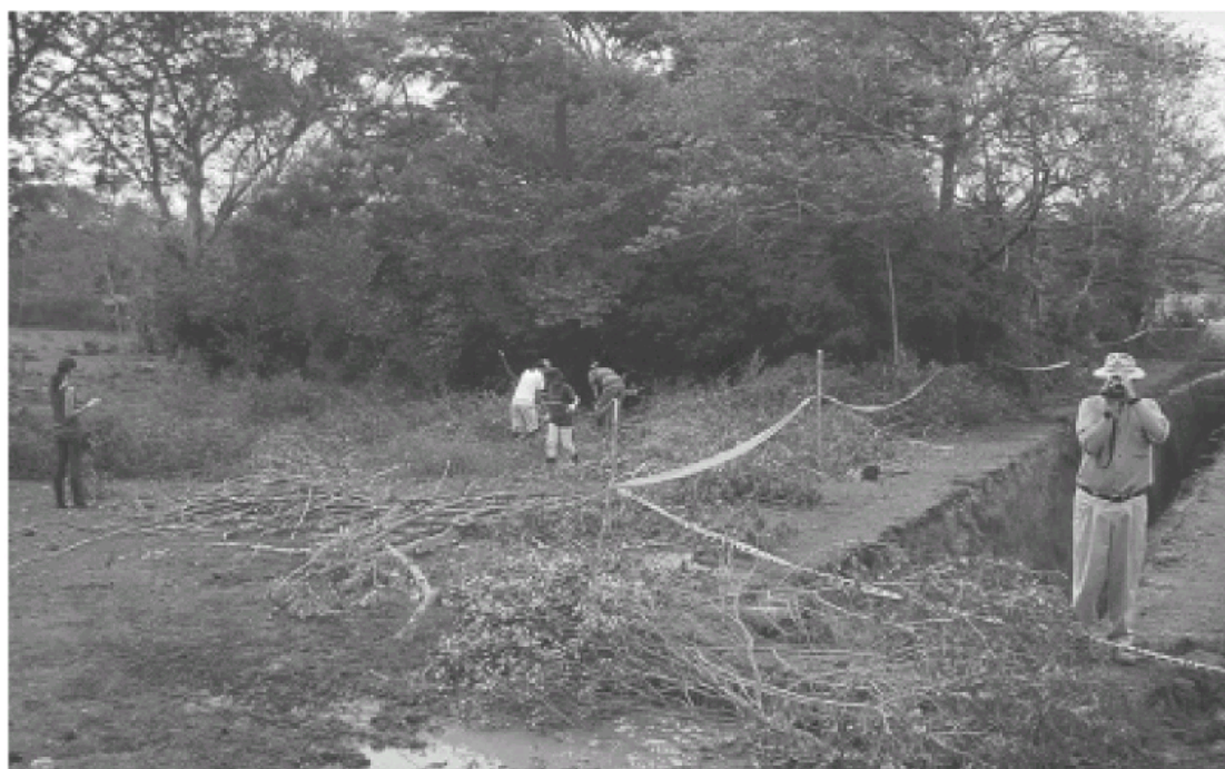
Figura 37. Trabajo de adecuación de troncos y palos generados en el descapote para cubrir el piso de la trinchera. Si se tiene guadua, es más fácil de colocar y permite un cómodo desplazamiento dentro de la trinchera.
